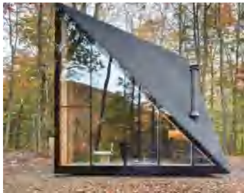
图 2-28 倾斜的屋顶与墙壁
