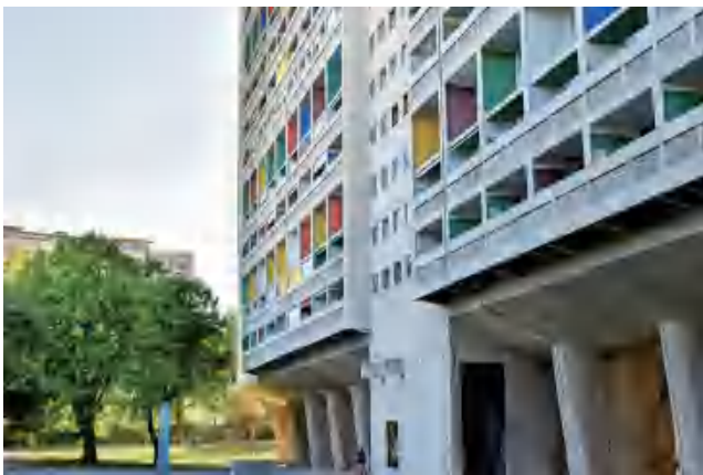
图 6-17 马赛公寓的混凝土柱墩
