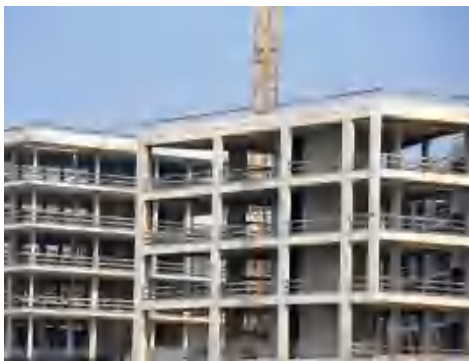
图1-24 钢筋混凝土建筑
