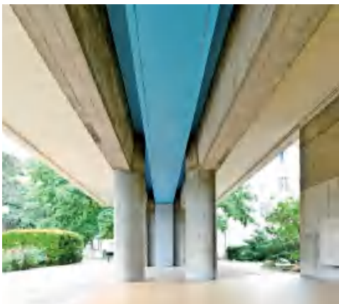
图6-15 巴黎瑞士学生宿舍的钢筋混凝土支柱
