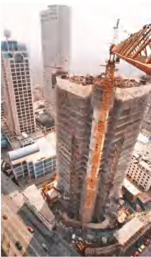
图 1-19 混凝土结构建筑
