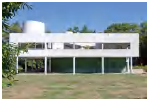
图6-11 萨伏伊别墅的西北侧外观
