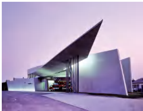
图 6-84 维特拉消防站的侧面
