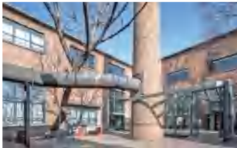
图 1-18 内蒙古工业大学建筑馆（改造前是内蒙古工业大学机械厂的铸工车间）
